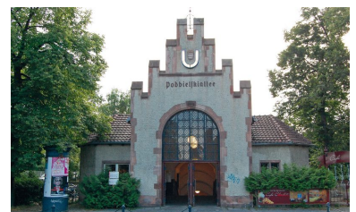
Am Ende der Schorlemmerallee und am Anfang der Einschnittstrecke steht das Empfangsgebäude der Station Podbielskiallee - Variation auf ein mittelalterliches Stadttor oder »eine Zwingburg als Bahnhof«, wie man 1913 spottete. Der Namenszug und das »U« sind später an der Fassade angebracht worden. (Foto: Jan Gympel)
