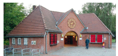
Besser sahen zeitgenössische Kritiker das hochmoderne Verkehrsmittel elektrische Schnellbahn durch das östliche Empfangsgebäude der Station Thielplatz repräsentiert: Es wurde offenkundig vom damals als wegweisend betrachteten Haus Freudenberg inspiriert, das nach Plänen von Hermann Muthesius 1907 bis 1908 in Nikolassee entstanden war. (Foto: Jan Gympel)
