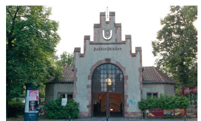
Am Ende der Schorlemmerallee und am Anfang der Einschnittstrecke steht das Empfangsgebäude der Station Podbielskiallee - Variation auf ein mittelalterliches Stadttor oder »eine Zwingburg als Bahnhof«, wie man 1913 spottete. Der Namenszug und das »U« sind später an der Fassade angebracht worden. (Foto: Jan Gympel)
