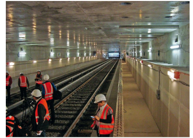
Die U 6 durchfährt seit dem 17. November 2013 den Rohbau-Bahnhof Unter den Linden. Die Bahnsteigplatten fehlen noch, ebenso die Anlagen der neuen U 5 unterhalb dieses U6-Bahnhofes. (Foto: Florian Müller, 29. Oktober 2013)
