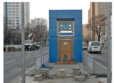
Schildbürgerstreich. Am U-Bf Magdalenenstraße ist seit Februar 2013 der Aufzug fertig. Aber weil die Verkehrslenkung Berlin die erforderliche Ampel zunächst nicht genehmigte, ist der Aufzug noch immer nicht in Betrieb. (Foto: Marc Heller)
