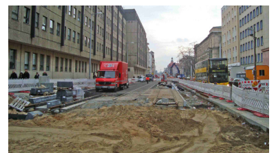
Die Kreuzung Chausseestr./Invalidenstr. ist noch immer eine große Baustelle, vor allem für die Erneuerung der Versorgungsleitungen. (Foto: Florian Müller)
