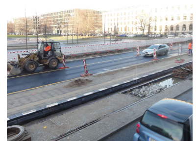
Aufgepflasterter Gleiskörper am Invalidenpark Richtung Hauptbahnhof; die Busse halten weiterhin am Straßenrand. In Gegenrichtung verschwenken die Fahrspuren zweimal über das Gleis, damit ein Halt am rechten Bordstein möglich ist - zusammen mit den Bussen. (Foto: Holger Mertens)
