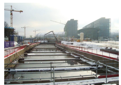
Die Baugrube der S 21 zum Hauptbahnhof ist Mitte Januar 2014 noch geflutet. Hier entsteht der Tunnel des 1. Bauabschnitts. (Foto: Florian Müller)
