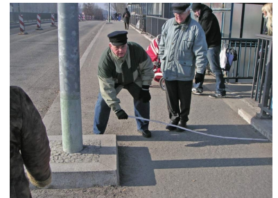
Neue Stolperfalle: Bei der Brückensanierung wurde nicht nur der Fußweg verkleinert, auch hat man zusätzlich neue Stolperfallen auf dem schmalen Steg installiert, wie Herr Schild von der Bürgerinitiative hier aufzeigt. (Foto: BI Berliner Luft)
