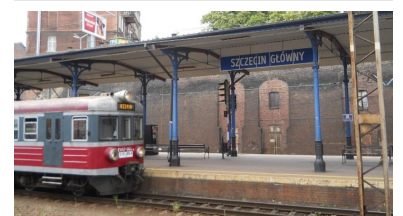
Verschlepptes Projekt: Erst 2020 soll die Strecke Berlin--Szczecin durchgehend elektrifiziert sein und dann endlich deutlich kürzere Fahrzeiten ermöglichen. (Foto: Sebastian Kliems)
