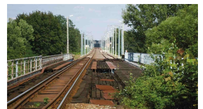
Die Neißebücke an der Grenze Deutschland/Polen bei Horka im Jahr 2008. Auf polnischer Seite (Hintergrund) ist die Strecke bereits zweigleisig und elektrifiziert. Nach jahrelangen Verzögerungen baut nun auch Deutschland seinen Teil aus. (Foto: IGEB)
