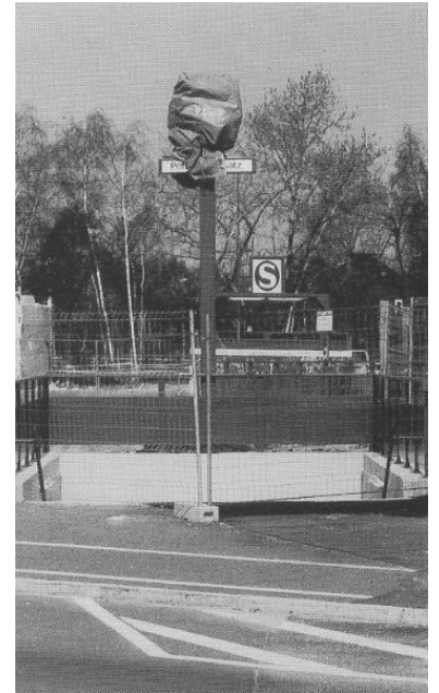
Pendelverkehre, geschlossene Bahnhofseingänge. Seit Jahren leiden die Fahrgäste unter den scheinbar unendlichen Bauarbeiten am Nord-Süd-Tunnel der S-Bahn. (Foto: Frank Lammers)
