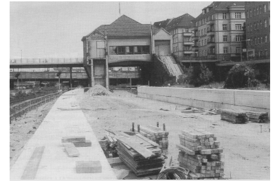
Sommer 1990. Vom alten S-Bahnsteig in Witzleben ist nichts mehr vorhanden. Vier Jahre lang wurde der Südring umfassend erneuert. Doch vier Monate nach der Wiederinbetriebnahme müssen sich die Fahrgäste auch auf dem Südring schon wieder mit Fahrplanänderungen durch Bauarbeiten herummärgern. (Foto: Heinz-Peter Schwarz)
