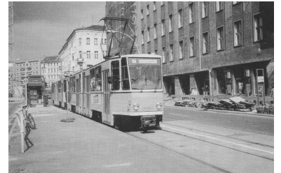
Auf der Friedrichstraße sind die Tram-Saboteure in den Amtsstuben derzeit besonders erfolgreich: Fehlende Netzverknüpfung zur Chausseestraße, häufige Betriebsunterbrechungen wegen Falschparkern auf den Tramgleisen und die stillgelegte Haltestelle (siehe Foto) am U-Bf Oranienburger Tor sorgen dafür, daß die Tram-Linie 1 für die Fahrgäste völlig unattraktiv und entsprechend schlecht besetzt ist. (Foto: IGEB)
