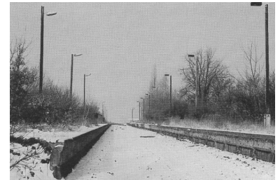
März 1994. Die Hamburger Bahn und der an dieser Strecke gelegene Bahnhof Albrechtshof liegen noch im Winterschlaf. Doch bald wird diese Strecke für den Fern- und Regionalverkehr ausgebaut. Schon Ende 1995 sollen auf einem Gleis die ersten Regionalzüge verkehren. Jetzt hat der brandenburgische Landtag beschlossen, daß hier und auf den anderen ehemaligen S-Bahn-Strecken bald auch wieder S-Bahn-Züge nach Berlin fahren sollen. (Foto: Frank Lammers)
