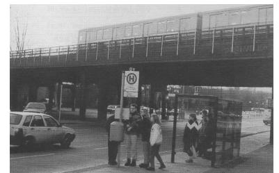
Warten auf den S-Bahn-Ersatzverkehr am S-Bf Tiergarten. (Foto: Frank Lammers)
