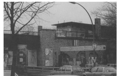
Während die Bauarbeiten für die Wiederinbetriebnahme der S-Bahn nach Lichterfelde Ost nach erheblichen Startschwierigkeiten seit 1993 zügig vorangehen, gibt es bei der S-Bahn nach Tegel immer wieder Verzögerungen. So ist zu befürchten, daß die nach mehrfachen Verschiebungen nun zum Fahrplanwechsel im Mai 1995 angekündigte Wiederinbetriebnahme nur auf der Anhalter, nicht aber auf der Kremmener Bahn erfolgen wird. Bild oben: Hochsommer. Die S-Bahn-Baustelle auf der Anhalter Bahn nahe Südende, Blickrichtung Priesterweg, im August 1994. Bild hier: Winterschlaf. Der S-Bf Eichbornstraße (künftig Eichborndamm) auf der Kremmener Bahn vor dem seit Jahren angekündigten, aber immer wieder verschobenen Baubeginn (Bild vom Februar 1994). (Foto: Bernhard Strowitzki)
