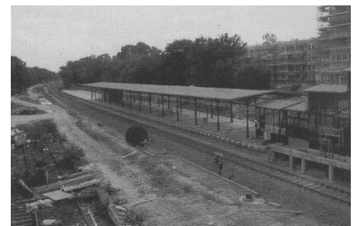
Der S-Bf Südende ist nach Abbruch und Wiederaufbau im Sommer 1994 bereits fast fertiggestellt. Auf der Brache im Vordergrund sollen die Fernbahngleise in Richtung Leipzig wiedererrichtet werden. Doch bis hier die ersten Züge mit geplanten 160 km/h in Berlin eintreffen, werden noch viele Jahre vergehen. (Foto: Bernhard Strowitzki)
