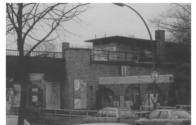
Während die Bauarbeiten für die Wiederinbetriebnahme der S-Bahn nach Lichterfelde Ost nach erheblichen Startschwierigkeiten seit 1993 zügig vorangehen, gibt es bei der S-Bahn nach Tegel immer wieder Verzögerungen. So ist zu befürchten, daß die nach mehrfachen Verschiebungen nun zum Fahrplanwechsel im Mai 1995 angekündigte Wiederinbetriebnahme nur auf der Anhalter, nicht aber auf der Kremmener Bahn erfolgen wird. Bild oben: Hochsommer. Die S-Bahn-Baustelle auf der Anhalter Bahn nahe Südende, Blickrichtung Priesterweg, im August 1994. Bild hier: Winterschlaf. Der S-Bf Eichbornstraße (künftig Eichborndamm) auf der Kremmener Bahn vor dem seit Jahren angekündigten, aber immer wieder verschobenen Baubeginn (Bild vom Februar 1994). (Foto: Bernhard Strowitzki)
