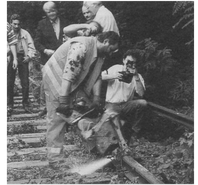
Wählertäuschung: Nach diesem "Spatenstich" am 14. August 1995 ruhten die Arbeiten zur Wiederinbetriebnahme der S-Bahn nach Hennigsdorf. (Foto: Marc Heller)
