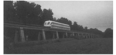
Transrapid-Versuchsstrecke im Emsland. In den Köpfen von Industrie und Bundesregierung rast der Transrapid aber bereits auf Berlin zu. Noch in diesem Jahr soll das Raumordnungsverfahren eröffnet werden, in dem auch die innerstädtische Trassenführung vorentschieden wird. Fast alle Fachleute erwarten, daß die Nordtrassen ausscheiden und eine Westtrasse (über den neuen Fernbahnhof Berlin-Spandau) ausgewählt wird. Damit verbleiben noch zwei Trassen zur Weiterführung, entweder über die Lehrter Bahn zum geplanten Zentralbahnhof am Lehrter Stadtbahnhof oder über den Südring zum geplanten Fernbahnhof Papestraße. Letztere ist die Vorzugstrasse der Magnetschnellbahn-Planungsgesellschaft mbH. (Foto: Matthias Horth)
