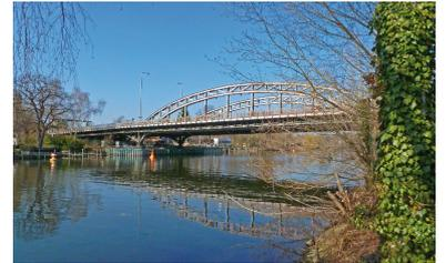
Die Freybrücke ist nicht mehr tragfähig, deshalb darf sie nur noch von Fahrzeugen bis 18 Tonnen befahren werden - das gilt auch für Busse. Die plötzliche Einschränkung führte zu einem Verkehrschaos für die Busfahrgäste. (Foto: Raul Stoll)
