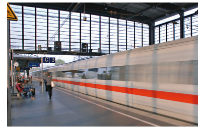
Berlin Zoologischer Garten. ICE-Züge werden auch künftig (noch) durchfahren. Aber der neue IRE Berlin--Hamburg wird ab 14. April hier halten. (Foto: Marc Heller)
