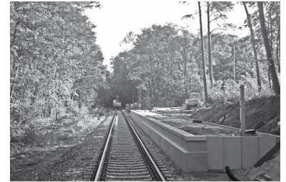
Endlich ist der Haltepunkt Bad Saarow Klinikum im Bau. Seitdem es in Fürstenwalde kein Krankenhaus mehr gibt, ist die Bahnverlängerung zum Klinikum in Bad Saarow noch wichtiger geworden. (Foto: Florian Müller, Anf. Oktober 2011)
