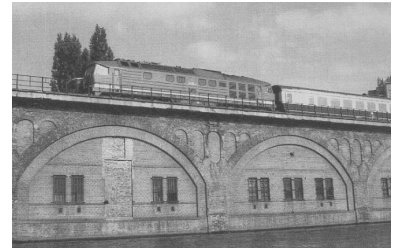
IC auf der Stadtbahn nahe S-Bf Jannowitzbrücke im September 1992. Derzeit fährt auf diesem Gleis die S-Bahn. Bis auch wieder Fernzüge über die Stadtbahn fahren können, werden nach jüngsten Meldungen noch mindestens zwei Jahre vergehen, da die Sanierungsarbeiten an der Viaduktstrecke länger als geplant dauern. (Foto: Thomas Billik)
