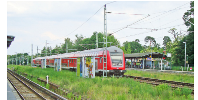
Griebnitzsee. Die Reste des ehemaligen Bahnsteigs sind unter dem Grasbewuchs zu erahnen. Der RE 1 befährt das Streckengleis Richtung Potsdam Hbf, an dem der Bahnsteig gebaut werden muss. Im Hintergrund der bestehende Regio-Bahnsteig Richtung Wannsee mit einem eigenen Bahnsteiggleis. Links der S-Bahnsteig. (Foto: Florian Müller, 2013)
