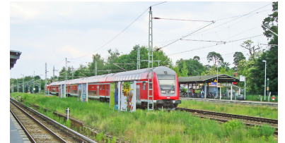
Griebnitzsee. Die Reste des ehemaligen Bahnsteigs sind unter dem Grasbewuchs zu erahnen. Der RE 1 befährt das Streckengleis Richtung Potsdam Hbf, an dem der Bahnsteig gebaut werden muss. Im Hintergrund der bestehende Regio-Bahnsteig Richtung Wannsee mit einem eigenen Bahnsteiggleis. Links der S-Bahnsteig. (Foto: Florian Müller, 2013)
