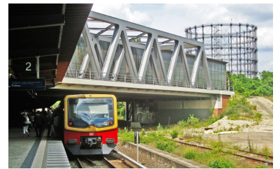
Die neugebaute Fachwerkbrücke für die Fernbahngleise auf dem Berliner Innenring am Bahnhof Schöneberg, im Hintergrund die Ringbahnhalle. Eigentlich sollten über die zweigleisige Brücke 2014 bereits Güterzüge mit Dieselloks verkehren. Doch nun wird dieses Bauwerk auf unbestimmte Zeit zur Invest-Ruine. (Foto: Florian Müller)
