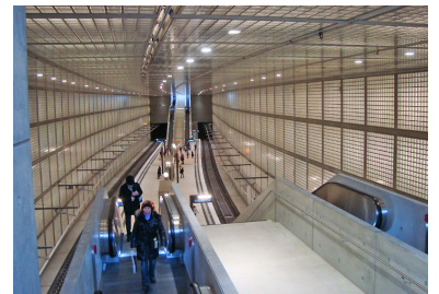
Am Wilhelm-Leuschner-Platz befindet sich die eindrucksvollste der neuen Leipziger Tunnelstationen. Ihre Bahnsteighalle wird geprägt von hinterleuchteten Glasbausteinen. (Foto: Florian Müller)
