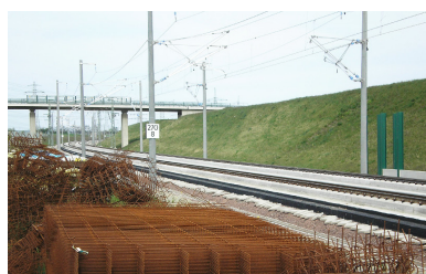
VDE-Projekt 8.2 (Erfurt--Halle/Leipzig): Die Bauarbeiten an der Schnellfahrstrecke sind inzwischen weit vorangeschritten. Zum Fahrplanwechsel im Dezember 2015 erfolgt die Betriebsaufnahme (Bauzustand bei Bad Lauchstädt im April 2014). (Foto: Christian Schultz)
