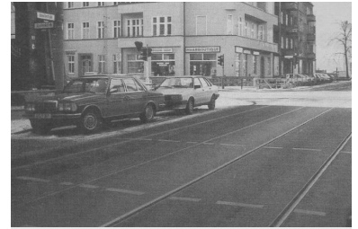
Schneller- Ecke Hasselwerderstraße. Die derzeit nicht genutzten Straßenbahngleise in der Treptower Schnellerstraße sollen herausgerissen werden. Weniger engagiert ist das Bezirksamt Treptow, wenn es um Erhalt und Ausbau der Straßenbahn geht. (Foto: I. Schmidt)
