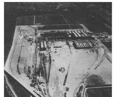
Zweimal Schöneweide aus der Luft. Das obere Bild, aufgenommen von Norden, zeigt am linken Rand eine große ungenutzte Freifläche, den späteren Standort des RAW Schöneweide. Rechts sind die umfangreichen Anlagen des Rangierbahnhofes und des Bw Schöneweide zu erkennen, im linken unteren Bildteil der noch heute erhaltene Wasserturm und die Abstellgleise für S-Bahn-Züge. Das untere Bild, auch von Norden aufgenommen, zeigt das zukünftige Reichsbahnausbesserungswerk im Bau: links die Wageneingangshalle, dahinter die große Werkhalle und daran anschließend der Verwaltungstrakt. Die kleinere separate Halle im Vordergrund ist die Lackiererei. (Foto: Landesarchiv Berlin (1927))
