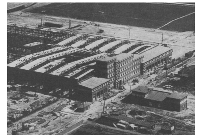
Luftaufnahme aus dem Jahre 1927. Sie zeigt das Verwaltungsgebäude und die daran anschließende Werkstatthalle im Bau. (Foto: Landesarchiv Berlin)
