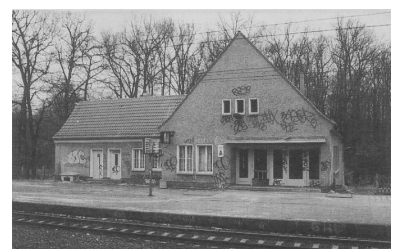
Völlig verfallend sind die Bahnhöfe Schönwalde (Kr Nauen) und Falkenhagen (Kr Nauen) auf dem Berliner Außenring. Mit dem Fahrplanwechsel am 2. Juni wird hier kein Zug mehr halten. Zwar liegen die Bahnhöfe abseits der Siedlungen, aber für Ausflüger aus dem nahen Berlin sind sie als Ausgangspunkt von Fuß- oder Radwanderungen gut geeignet. (Foto: Marc Heller)
