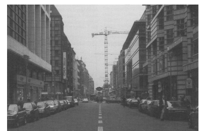
Die Friedrichstraße, Blick nach Norden zum U-Bf Französische Straße. Die Bauarbeiten an den Hochbauten und den Bahnsteigverlängerungen der U6 sind weitgehend abgeschlossen, die Fahrbahn ist wiederhergestellt. Aber von Straßenbahngleisen ist nichts zu sehen. Für deren Realisierung wurde noch nicht einmal mit dem förmlichen Planverfahren begonnen. Dabei hatte der Senat 1993 doch beschlossen: &#8222;Die Senatsverwaltung für Verkehr und Betriebe wird beauftragt sicherzustellen, daß die erforderlichen Baumaßnahmen an den U-Bahnhöfen der Linie 6 im Streckenabschnitt zwischen den Bahnhöfen Friedrichstraße und Stadtmitte zeitlich so mit den Tiefbaumaßnahmen ... einschließlich der Baumaßnahmen für den beabsichtigten Straßenbahnverkehr koordiniert werden, daß eine weitestgehend gleichzeitige Fertigstellung
