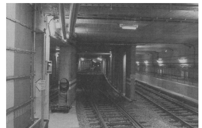
Blick vom südlichen Bahnsteigende des U-Bfs Hermannstraße auf die üppig dimensionierte Treppenanlage zur Silbersteinstraße und die lange Zeit umstrittenen Keh- und Aufstellgleise. Auch die außenliegenden Streckengleise können zum Aufstellen genutzt werden. Eine Verlängerung der U8 nach Britz wird es in den nächsten 20 Jahren sicher nicht geben (Foto: Marc Heller)
