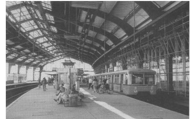
Erneute Verschiebung. Nun soll die Rückverschwenkung der Stadtbahn von den Fernbahn- auf die S-Bahn-Gleise zum 26.8. und 21.10. erfolgen. Davon ausgenommen ist aber noch der Bf Friedrichstraße, die Züge weiterhin den Bahnsteig B (siehe Bild) anfahren müssen. (Foto: Marc Heller)
