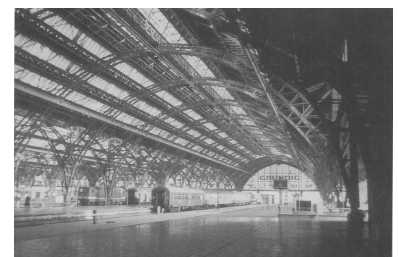
Leipzig Hbf. Auf der Ausbaustrecke Berlin - Halle/Leipzig sind die Arbeiten für das VDE Nr. 8 am weitesten vorangeschritten (Foto: Johann Hartl)
