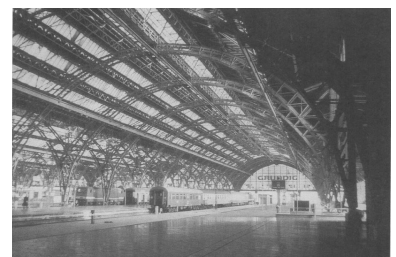
Leipzig Hbf. Auf der Ausbaustrecke Berlin - Halle/Leipzig sind die Arbeiten für das VDE Nr. 8 am weitesten vorangeschritten (Foto: Johann Hartl)
