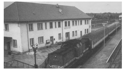
Unsinn der DB-Unternehmensstruktur: Jeweils separate Räume werden im Gebäude des Bahnhofes Küstrin-Kietz sowohl durch das Service-Team des Geschäftsbereiches Personenbahnhöfe (vorne links) als auch durch den Fahrkartenschalter der Geschäftsbereiche Fern- und Nahverkehr (Mitte) unterhalten. Während das Büro des - sichtlich unterforderten - Service-Teams täglich von 10 bis 19 Uhr geöffnet ist, beschränkt sich der Fahrkartenschalter auf die Zeiten montags bis mittwochs und freitags von 6.30 bis 14.30 Uhr sowie donnerstags von 6.30 Uhr bis 12.30 Uhr (Foto: Stephan Müller)
