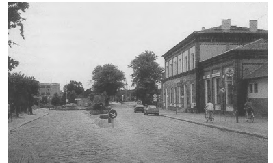
Gute Voraussetzungen für die Integration von Bus und Bahn: Der neugestaltete Bahnhofsvorplatz in Belgiz macht das Umsteigen einfach. Was heute fehlt, ist die gegenseitige Linienabstimmung. Der Bestand der Bahnlinie Belgiz - Brandenburg (Havel) ist derzeit vor allem durch den dichten Busparallelverkehr und die bisher nicht vollzogene Einrichtung neuer Bahnhaltspunkte äußerst gefährdet. (Foto: Stephan Müller)
