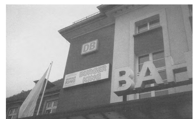
Beispiel Frankfurt (Oder): Bahnhof oder Burger King? Das Bahnhofsareal wartet dringend auf Neugestaltung. Die Wege zwischen Zügen, Bussen und Straßenbahnen sind heute sehr lang, das Bahnhofsgebäude im 50er Jahre-Charme. (Foto: Stephan Müller)
