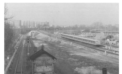
Der von Tegel kommende »Franzosenzug« unterfährt die Ringbahnbrücke nördlich des Güterbahnhofs Charlottenburg (Bild oben im Sommer 1983). Hier ist ein völlig neues Überführungsbauwerk für die S-Bahn entstanden, der genietete Stahl mußte einer Betonkonstruktion weichen (Bilder Mitte und unten im Dezember 1996). Das untere Foto wurde von der Spandauer-Damm-Brücke am S-Bf Westend aufgenommen und zeigt die wiederhergestellte Ringbahn zum S-Bf Jungfernheide mit Kehrzug. (Foto: Marc Heller)
