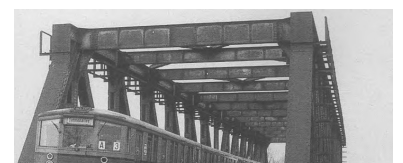
Der von Tegel kommende »Franzosenzug« unterfährt die Ringbahnbrücke nördlich des Güterbahnhofs Charlottenburg (Bild oben im Sommer 1983). Hier ist ein völlig neues Überführungsbauwerk für die S-Bahn entstanden, der genietete Stahl mußte einer Betonkonstruktion weichen (Bilder Mitte und unten im Dezember 1996). Das untere Foto wurde von der Spandauer-Damm-Brücke am S-Bf Westend aufgenommen und zeigt die wiederhergestellte Ringbahn zum S-Bf Jungfernheide mit Kehrzug. (Foto: Marc Heller)
