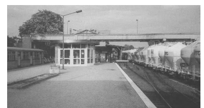
Noch immer sind keine Mittel für den gleistechnischen Umbau des Bahnhofes Strausberg bereitgestellt. Das Gleis, das hier der Güterzug befährt, wird auch gleichzeitig durch die S-Bahn-Züge von und nach Strausberg Nord sowie die Regionalbahn 25 von und nach Küstrin genutzt und ist deshalb ein gravierender Engpaß für die Fahrplangestaltung. (Foto: Stephan Müller)
