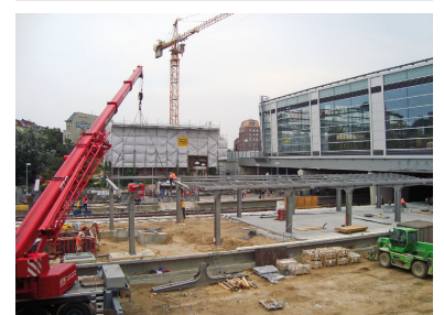
Bau des Bahnsteigs D am Ostkreuz. Wenigstens die neuen S-Bahnsteige D und E auf der Stadtbahnseite erhalten ja ein Dach. (Foto: ...)
