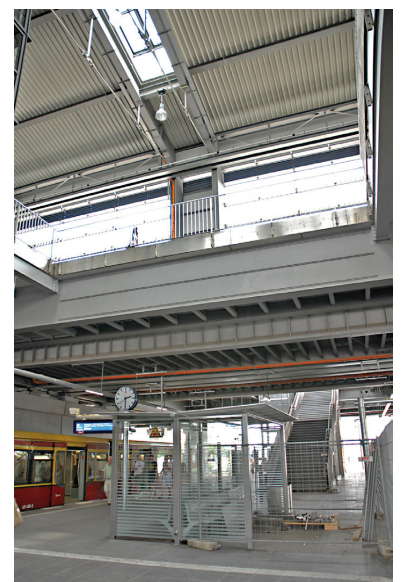
Überdachte Wartehalle (Ru) unter der Ringbahnhalle. Wozu? (Foto: Marc Heller)
