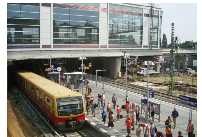
Hier sehen Sie KEIN Dach - dieses will die DB einsparen. (Foto: Florian Müller)
