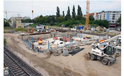
Baugrube für eine weitere Verlängerung der Autobahn A100. Hier werden Vorleistungen für einen doppelstöckigen Autobahntunnel unter dem Ostkreuz gebaut. Die Arbeiten beeinträchtigen und verzögern den Umbau der Bahnanlagen erheblich. (Foto: Marc Heller)
