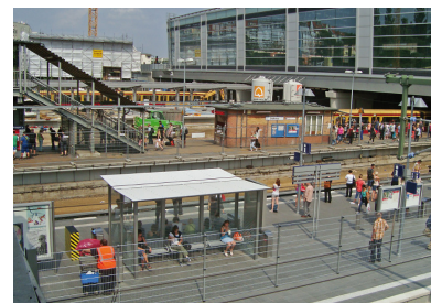
Ostkreuz, Bauzustand Stadtbahnebene Ende Juli 2014. Im Vordergrund der Regio-Bahnsteig Ru, an dem ab Ende 2017 die Regionalzüge von der Stadtbahn (RE 1, RE 2, RE 7, RB 14) halten sollen. Seit 30. Juni 2014 wird dieser Bahnsteig provisorisch für drei Jahre von der S 3 genutzt. Dahinter der alte S-Bahnsteig E mit dem letzten charakteristischen Bahnsteighäuschen. Dieser Bahnsteig wird im Herbst 2014 abgerissen. Wiederum dahinter entsteht der neue S-Bahnsteig D mit einem Dach. Rechts befindet sich die 2012 fertiggestellte neue Ringbahnhalle mit dem S-Bahnsteig F. (Foto: Florian Müller)
