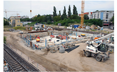
Baugrube für eine weitere Verlängerung der Autobahn A100. Hier werden Vorleistungen für einen doppelstöckigen Autobahntunnel unter dem Ostkreuz gebaut. Die Arbeiten beeinträchtigen und verzögern den Umbau der Bahnanlagen erheblich. (Foto: Marc Heller)
