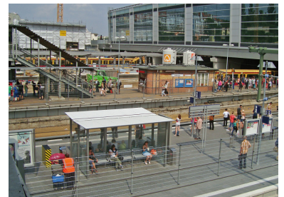
Ostkreuz, Bauzustand Stadtbahnebene Ende Juli 2014. Im Vordergrund der Regio-Bahnsteig Ru, an dem ab Ende 2017 die Regionalzüge von der Stadtbahn (RE 1, RE 2, RE 7, RB 14) halten sollen. Seit 30. Juni 2014 wird dieser Bahnsteig provisorisch für drei Jahre von der S 3 genutzt. Dahinter der alte S-Bahnsteig E mit dem letzten charakteristischen Bahnsteighäuschen. Dieser Bahnsteig wird im Herbst 2014 abgerissen. Wiederum dahinter entsteht der neue S-Bahnsteig D mit einem Dach. Rechts befindet sich die 2012 fertiggestellte neue Ringbahnhalle mit dem S-Bahnsteig F. (Foto: Florian Müller)
