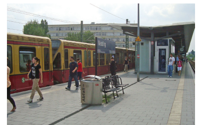
Mangelhaft! Der wichtige S-Bahnhof Wedding ist zur Hälfte nicht überdacht, ebenso wie der stark frequentierte S-Bahnhof Charlottenburg. (Foto: Florian Müller)
