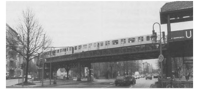
Zug der 1)15 am U-Bf Schlesisches Tor. Zum Fahrplanwechsel sollen die Züge entsprechend den neuen Ladenöffnungszeiten länger von Uhlandstraße bis Warschauer Straße verkehren. (Foto: Marc Heller)
