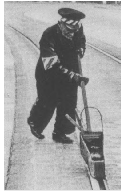
Ein Ritzenschieber. Zur Reinigung der Rillenschienen hatte der Arbeiter sein besonderes Gerät in den Gleisen entlangzudrücken. (BVG-Foto) (Foto und Text aus: &#8222;Noch jemand ohne Fahrschein?&#8220;)
