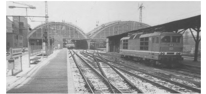
Berlin Hauptbahnhof von Osten gesehen. Dieser Fernbahnhof ist derzeit völlig unzureichend in den DB-Verkehr einbezogen und ab Fahrplanwechsel für ein Jahr gar nicht mehr nutzbar, mit Ausnahme der S-Bahn. In dieser Zeit wird das östliche Gleisvorfeld umgestaltet und erneuert. Ersatzbahnhof wird Berlin-Lichtenberg. Lediglich für die RE1-Ost wird am Bf Warschauer Straße ein Behelfsbahnsteig gebaut. (Foto: Christian Schultz)
