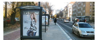
FALSCH: Neue Kaphaltestelle an der Landsberger Allee/ Karl-Lade-Straße. Der Radweg führt hinter den Haltestellenhäuschen entlang. Radfahrer sind für aussteigende Fahrgäste damit »unsichtbar«. (Foto: Tom Gerlich)
