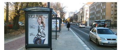
FALSCH: Neue Kaphaltestelle an der Landsberger Allee/ Karl-Lade-Straße. Der Radweg führt hinter den Haltestellenhäuschen entlang. Radfahrer sind für aussteigende Fahrgäste damit »unsichtbar«. (Foto: Tom Gerlich)
