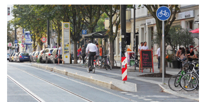
BESSER: In der Kastanienallee (hier Haltestelle Schwedter Straße) wird der Radweg nun über das Haltestellenkap geführt. Radfahrer und Fahrgäste können sich gegenseitig sehen. Auch Autofahrspuren können so über ein Kap geführt werden, um einen barrierefreien Einstieg zu ermöglichen und die Sicherheit zu erhöhen. (Foto: Tom Gerlich)
