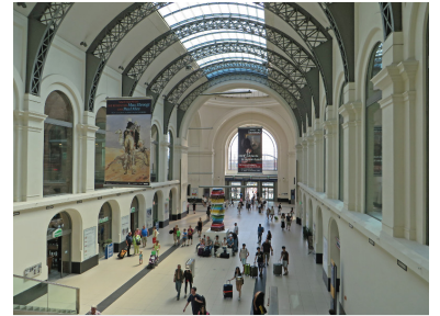
Bei der Sanierung von Dresden Hbf hervorragend gelungen: Die Verknüpfung von historischer Pracht mit den Anforderungen an ein zeitgemäßes Dienstleistungsangebot. (Foto: Sebastian Kliems)
