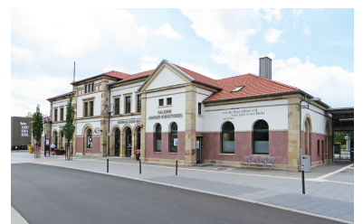
Hünfeld, Kleinstadtbahnhof des Jahres 2014. In Hünfeld ist mit dem Umbau ein mobilitätsgerechter Vorzeigebahnhof entstanden. Die Gestaltung attraktiver Stationen setzt dabei das Engagement der Kommunen voraus. (Foto: Christian Schultz)
