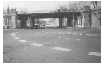
Während die Arbeiten an der S-Bahn-Trasse in Lichterfelde Süd inzwischen gut vorangekommen (Bild oben), gefährdet der Streit um die Breite der Brücke über die Königsberger Straße den Terminfahrplan. Eine Wiederinbetriebnahme zwischen Lichterfelde Ost und Süd noch im Jahr 1997 ist somit kaum noch möglich. (Foto: Jörg Rasch)
