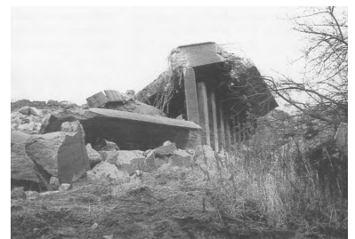
Überführung der Anhalter Bahn über die einst geplanten Verbindungsgleise zum Güteraußenring. Das Bauwerk zwischen Lichterfelde Süd und Teltow wurde jetzt im Zuge des Ausbaues der Anhalter Bahn für den Regionalverkehr gesprengt. (Foto: Jörg Rasch)
