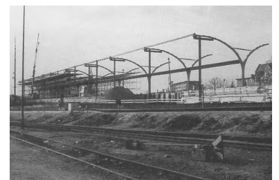
Bahnhof Berlin-Spandau, obener alte Bahnhof mit IC nach Hamburg, rechts der neue, noch im Bau befindliche. (Foto: Marc Heller (3/97))
