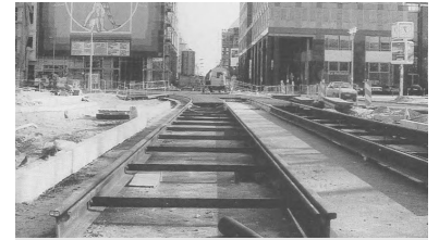
Friedrich- Ecke Dorotheenstraße, Blick nach Süden. Wenn die Straßenbahn eines Tages nach Süden verlängert wird, muß die Kreuzung für den Weicheneinbau wieder aufgerissen werden. Doch derzeit wird bei der Senatsverkehrsverwaltung nicht einmal an der Planung dieses Projektes gearbeitet, denn Staatssekretär Ingo Schmitt ist gegen die Tram-Verlängerung. (Foto: Marc Heller (4/97))
