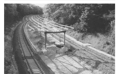
Wiederaufbau der S-Bahnstation Olympiastadion
