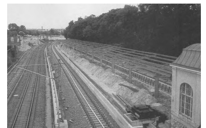
Wiederaufbau der S-Bahnhöfe Eichkamp (Bild oben mit Regionalbahn von Falkensee nach Berlin-Charlottenburg) und Heerstraße. Jeweils nördlich der S-Bahn-Gleise befindet sich die fertiggestellte Bahnstrecke Berlin - Hamburg. (Foto: Marc Heller (6/97))
