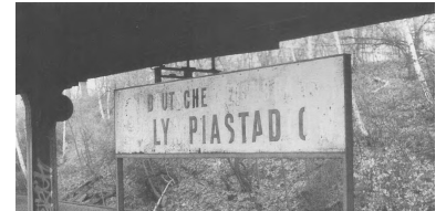
Vierzehn Jahre nach der Stilllegung ist der S-Bf Olympiastadion nur noch eine Ruine. Doch die einstige Bedeutung ist noch ablesbar. (Foto: Ivo Köhler (1994))
