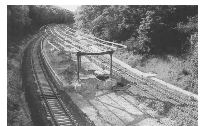
Wiederaufbau der S-Bahnhöfe Olympiastadion
