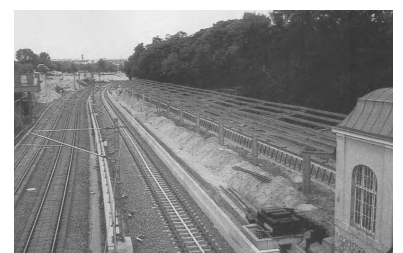
Wiederaufbau der S-Bahnstation Eichkamp (Bild oben mit Regionalbahn von Falkensee nach Berlin-Charlottenburg) und Heerstraße. Jeweils nördlich der S-Bahn-Gleise befindet sich die fertiggestellte Bahnstrecke Berlin - Hamburg. (Foto: Marc Heller (6/97))
